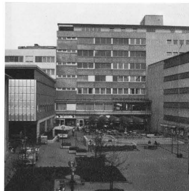
Co-op, Friedrichsbau und Parkhaus in Göppingen
